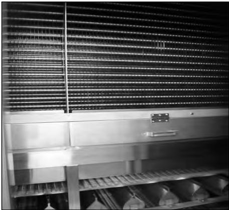
写真③ クーラーの材質は銅管・銅フィン
