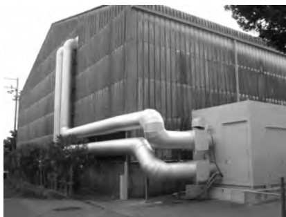
図10 フィールド試験の設置状況
